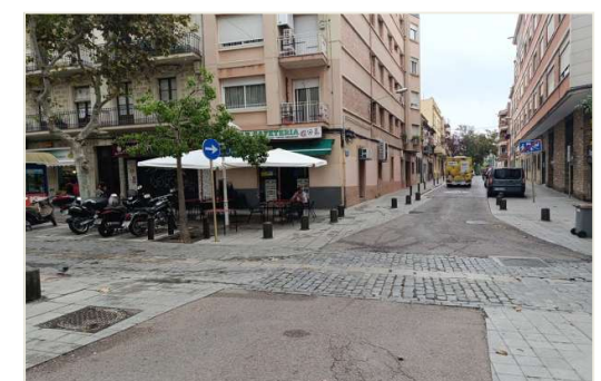
13. cruïlla Verge del Pilar
