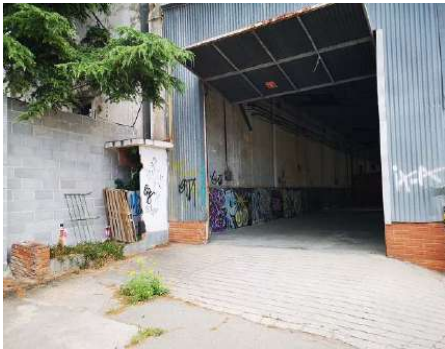
Sortida d'una de les ximeneies de ventilació del refugi
