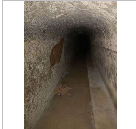
Interior refugi 2019 Estudi d'Arq. Pujol
