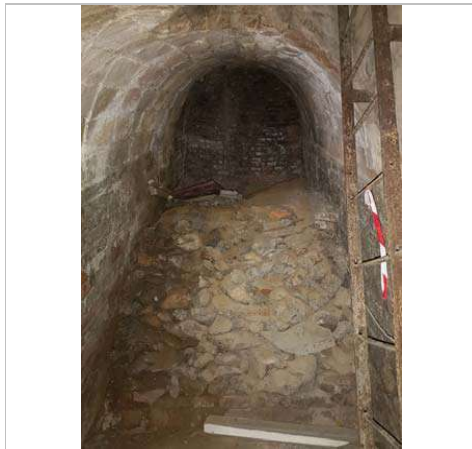
Interior refugi 2019 Estudi d'Arq. Pujol
