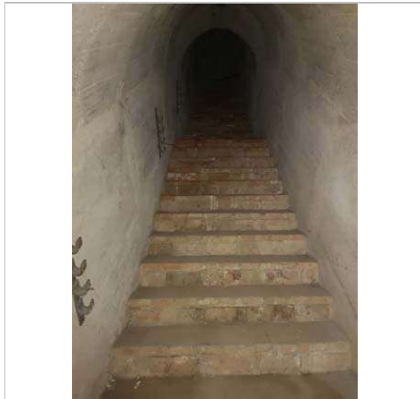
Accés interior 2019 Estudi d'Arq. Pujol
