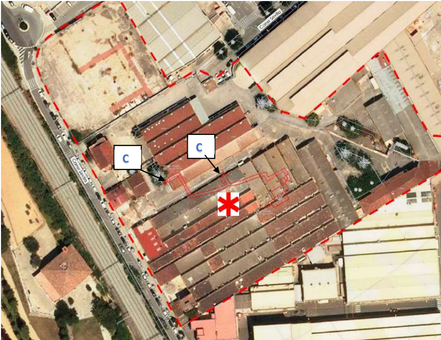
Ubicació del refugi en ortofotoplà, senyalització C xemeneia de ventilació
