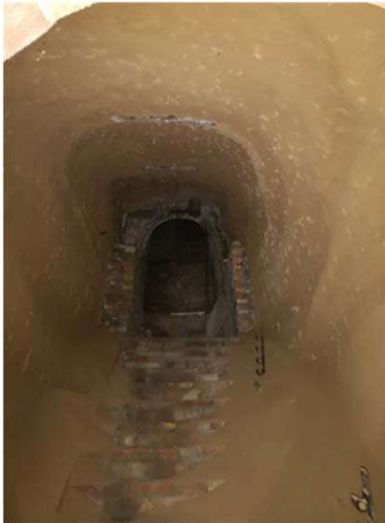
Escala enrunada i tapiada accés A.2019
