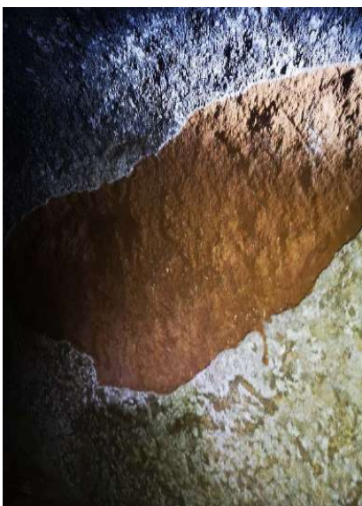
Galeries de terra, revocada amb morter ciment.2019
