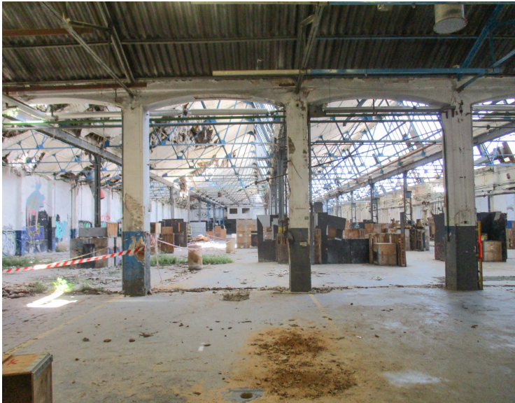
Imatge general de la nau a enderrocar. En primer pla tindriem l'espai corresponent a parcel·la 22a/t. Al fons de la nau el que serà la parcel·la 22a.1. L'espai de dins la nau que queda més a la dreta es preveu que ja quedi fora de l'àmbit de les parcel·les, i no ha mostrat problemes de alteració del subsol.
