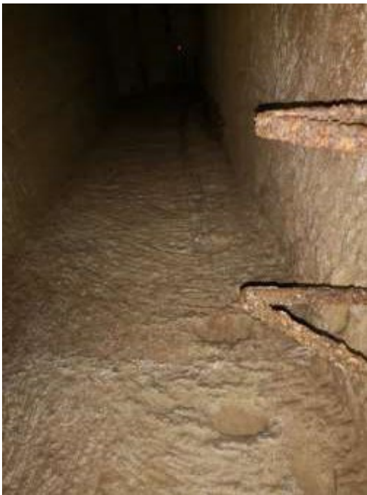
Detall dels sistemes de ventilació excavats a la Roca
