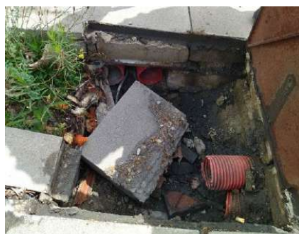
Foto 4. Arqueta 60 con el marco roto
